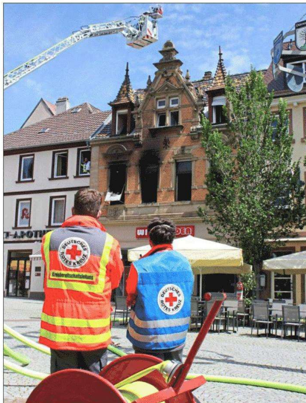
Unbewohnbar: Das Gebäude am Marktplatz wurde unter anderem als Anschlussunterbringung genutzt. Die Bewohner werden anderweitig untergebracht.
