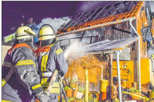
DIE EINSATZKRÄFTE der Brettener Feuerwehr hatten den Brand rasch unter Kontrolle gebracht. Die Ursache ist noch ungeklärt. Foto: Geier
